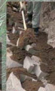
植栽土充填作業
