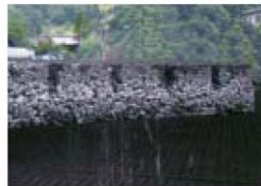
ポーラス層が水を地中へ浸透させます。
